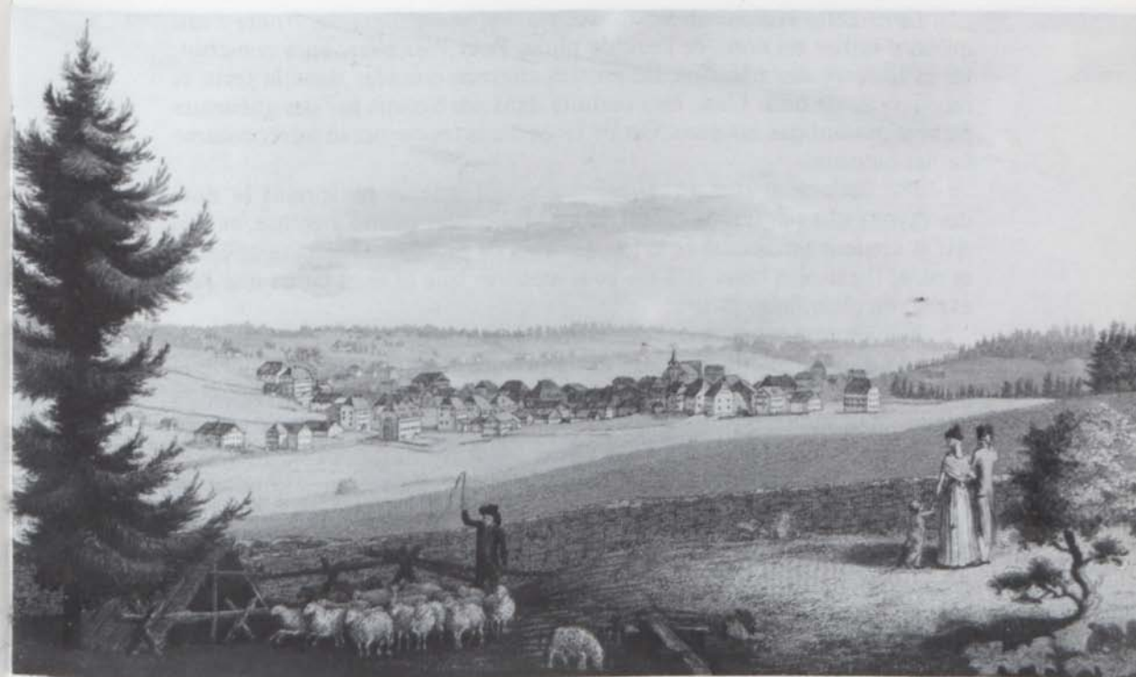
Vue de la Chaux-de-Fonds. Dans le Comté de Vallengin en Suisse; Dessiné du côté du Midy.
